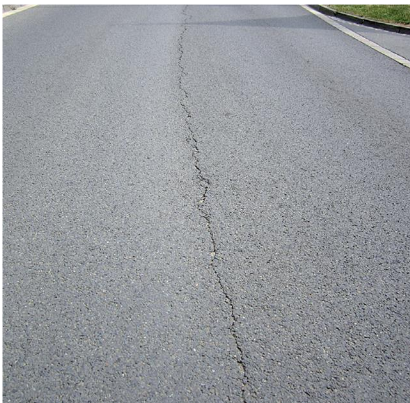
Obrázok 6 – Pozdĺžna reflexná trhlina
