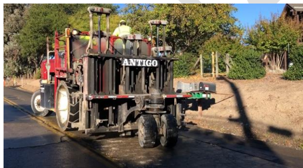
Obrázok 9 metóda "Crack and seat"
