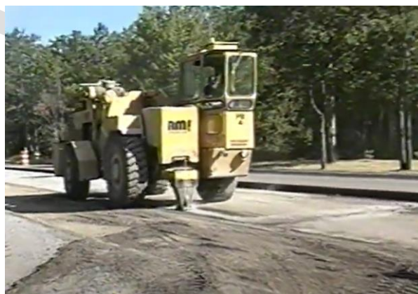
Obrázok 10 metóda "Rubblisation"
